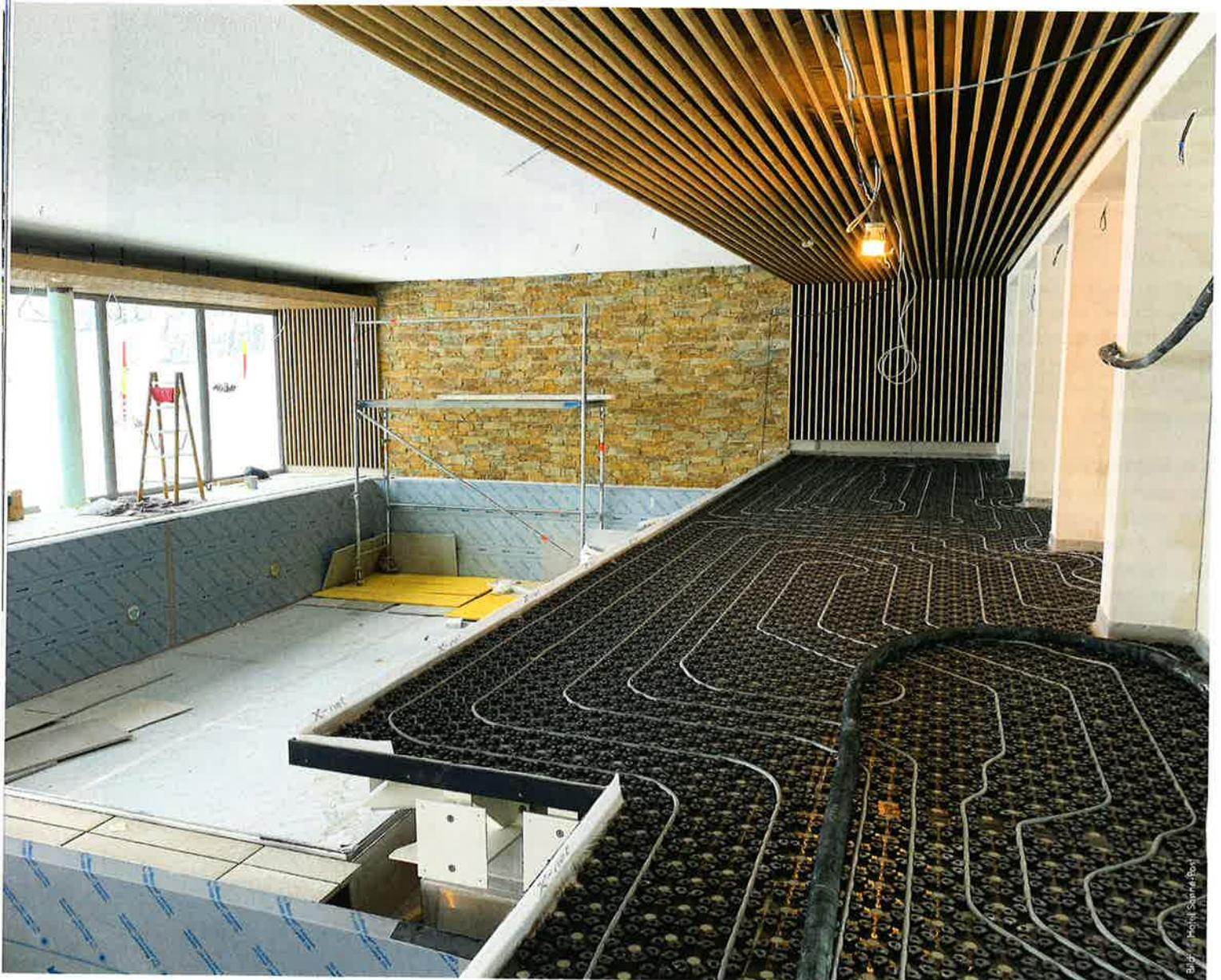
4 | Im Schwimmbad, den Saunen und für die Fußbodenheizung der Hotelzimmer wird die Geothermie vorrangig genutzt, denn dafür reichen 35 °C Vorlauf-temperatur, ideal für den Betriebskosten sparenden Betrieb der Wärmepumpe.
