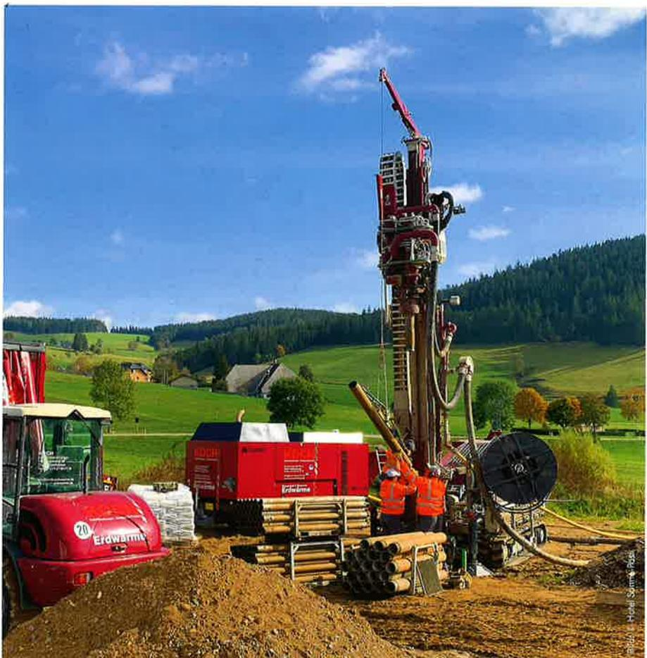
3 | Im Abstand von 10 m wurden auf dem Hotel-Grundstück 23 Geothermie-Sonden in 160 m Tiefe platziert. Sie können 68 Prozent des Wärmebedarfs decken. Die Wärmepumpe entnimmt ganzjährig 4 K Energie zwischen Vor- und Rücklauf.
