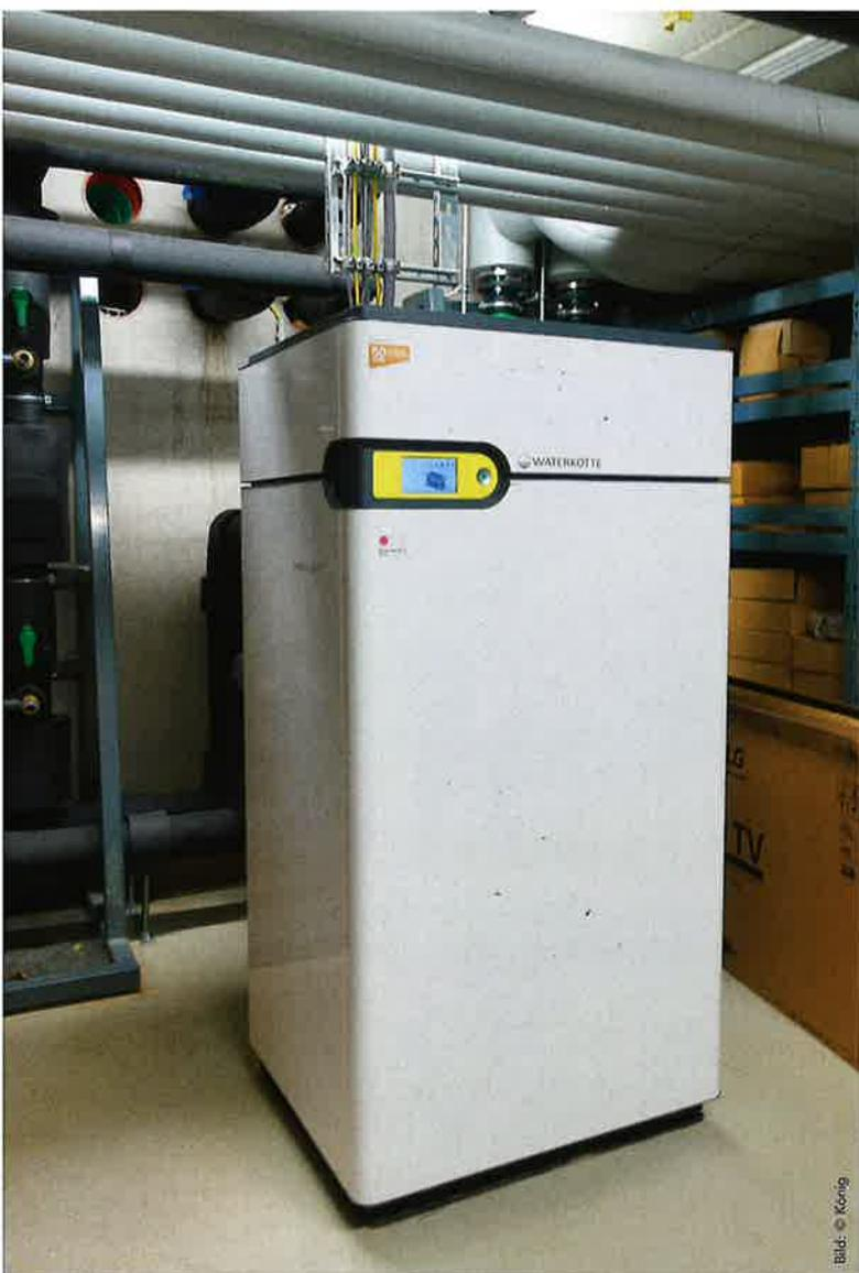
5 | Die verbaute Wärmepumpe verfügt über eine Leistung von 80 kW. Die Geothermie-Sonden in 160 m Tiefe liefern 10 °C Quelltemperatur. Mit 35 °C und einer JAZ von 5-6 wird im Sommerbetrieb das Schwimmbad beheizt und Warmwasser vorgewärmt.
